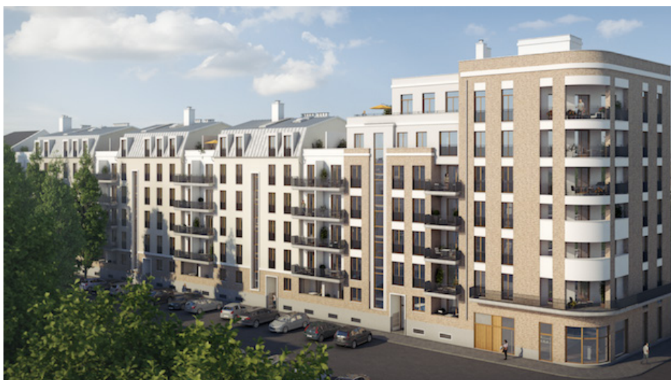
Frankfurt am Main, Hedderichstraße – Wohn- und Geschäftshaus mit moderner Wohnraumlüftung und Technologie der airfinity GmbH und exceet electronics GmbH. Quelle: airfinity
